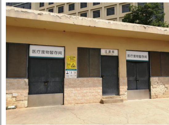
现有医疗废物暂存间
